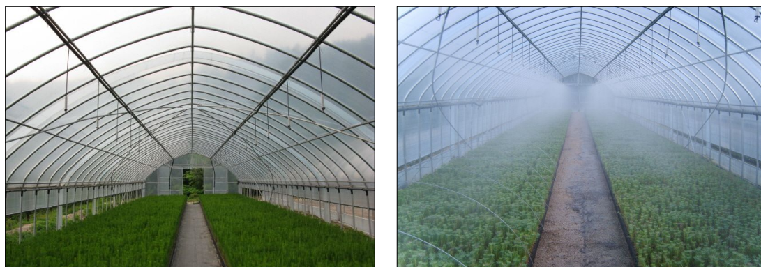
그림 3-25. 비닐온실 관수시설(하향식 스프링클러)
