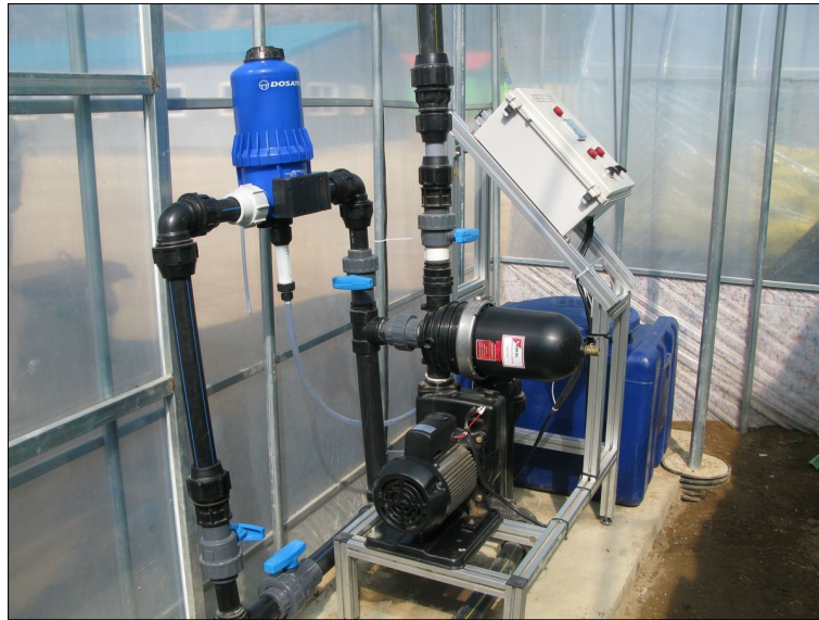
그림 3-26. 반자동조절 양액 시비시스템
