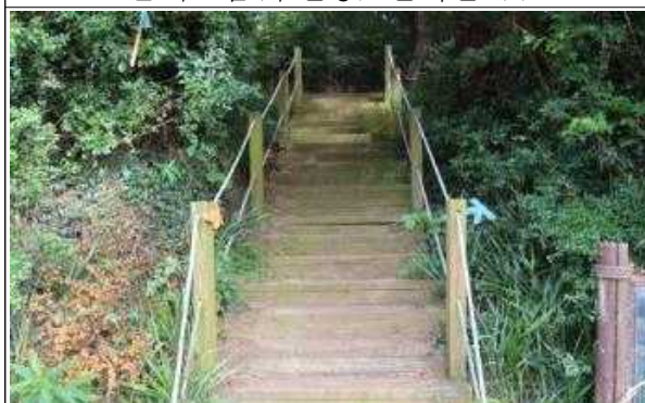
탐방로에 설치된 목재 계단
