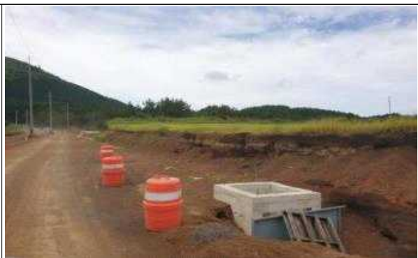
다랑쉬오름 진입로 확포장 공사
