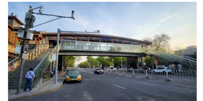
유리창 거리의 동서를 가르는 풍교(楓橋)형식의 육교
