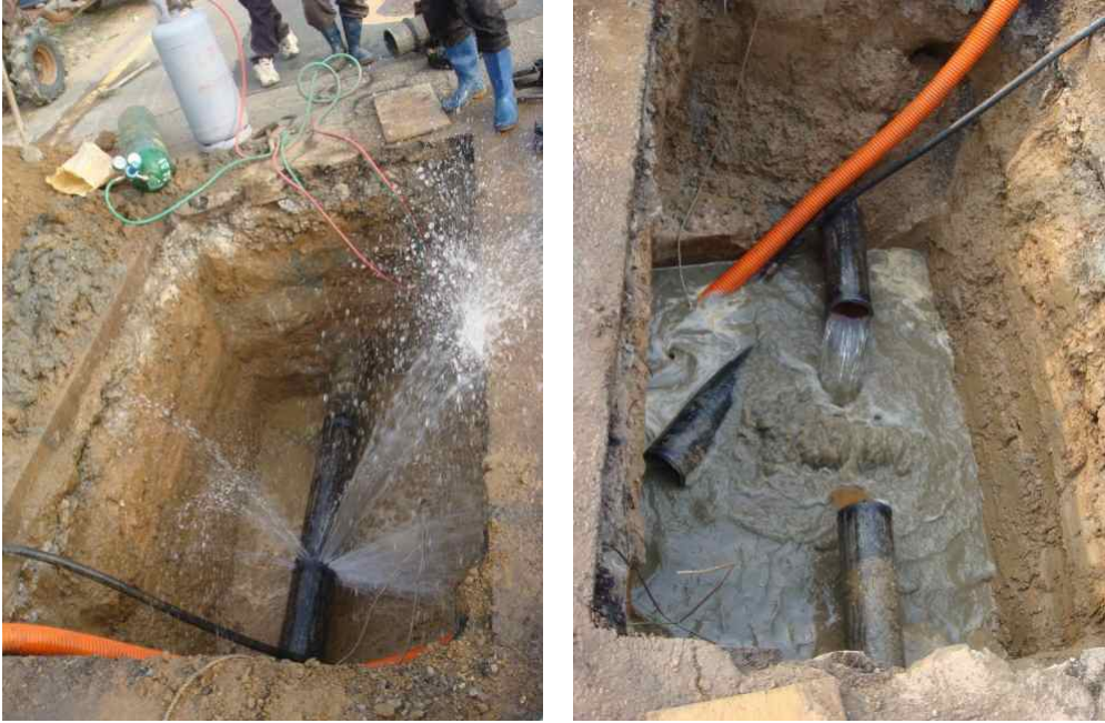
<그림 2-1> 상수관의 파손 및 교체
