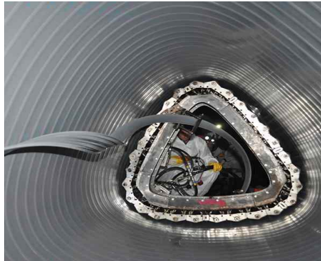
<그림 17> 특수 기계를 활용한 나선형 와인딩(Spiral Winding) 시공 현장
