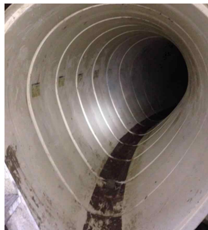
<그림 10> 패널(Panel) 라이너가 적용된 부분관 삽입 공법 관내 시공 전경
