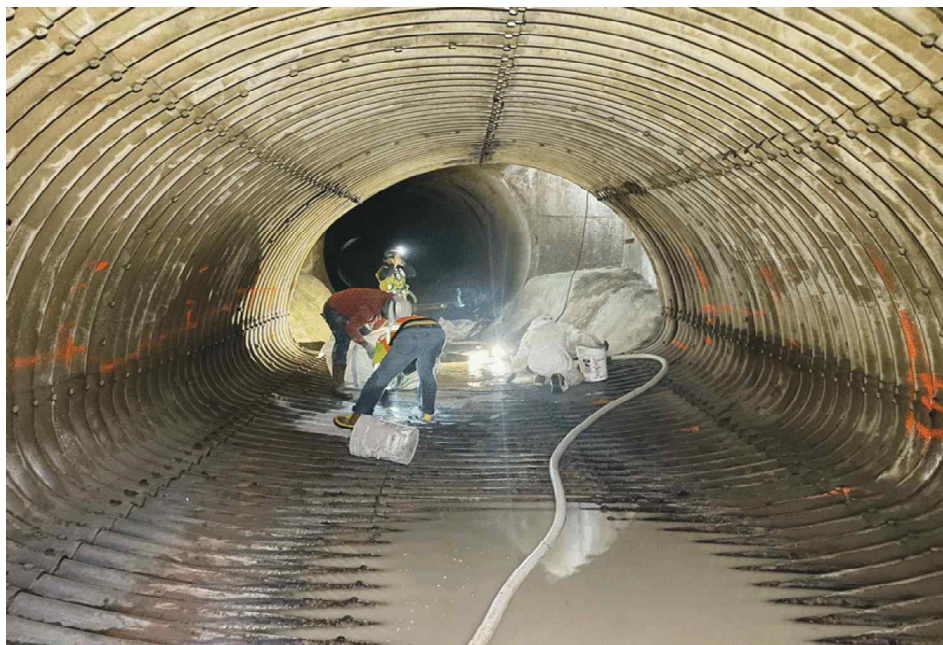
<그림 22> 내부성형 시공 예시
