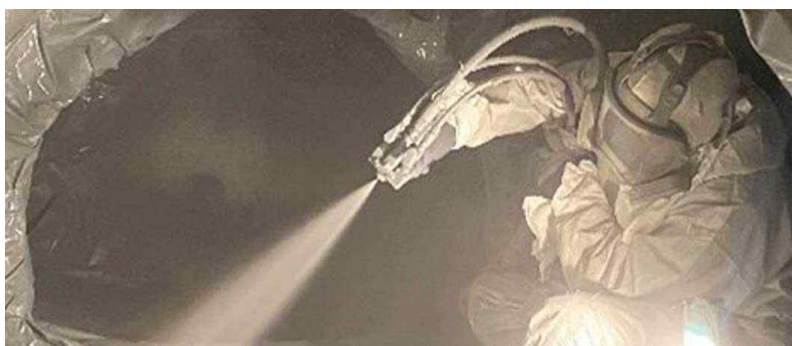
<그림 19> 합성수지 라이닝(Polymeric Materials Lining) 시공 예시
