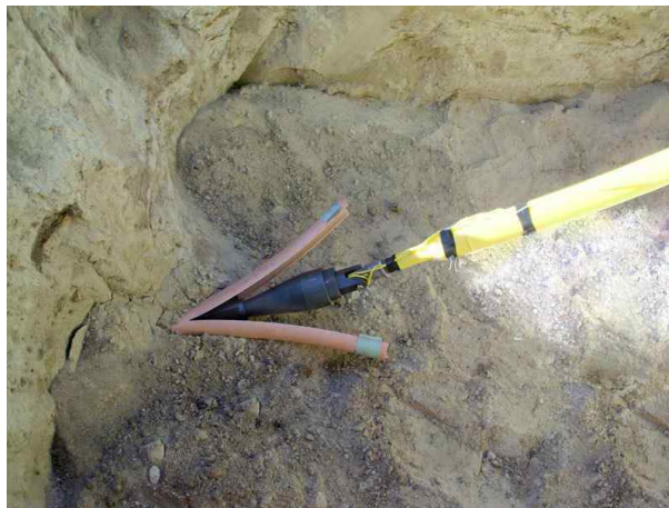
<그림 24> 관로 분할(Pipe Splitting) 공법의 시공 현장
