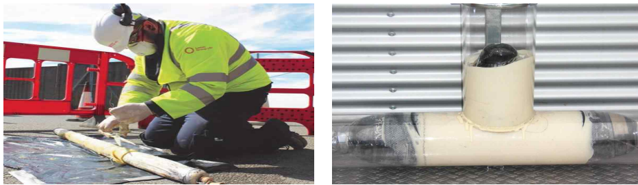
<그림 6> 현장 경화 패치(CIPR)에 사용되는 패커 조립 및 연결관 라이닝 시공 예시
