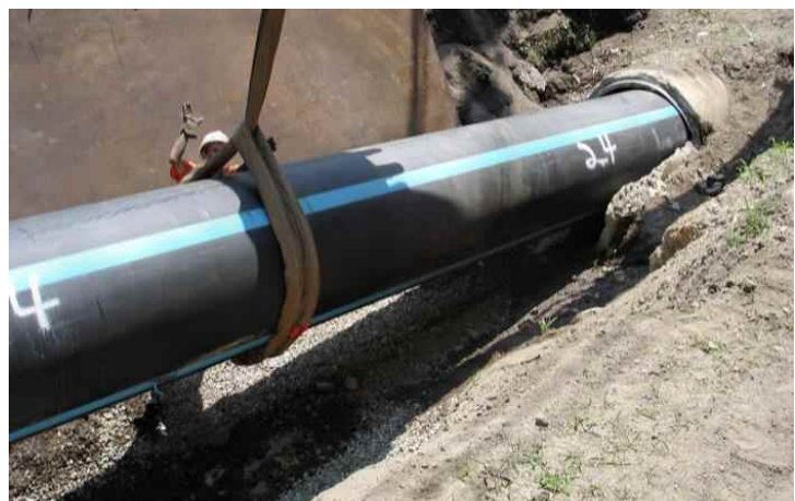
<그림 8> 연속관(Continuous Pipe) 삽입 공법 모식도 및 시공 예시
