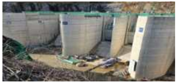
<유입부 구조물 설치현황(11.30)>
