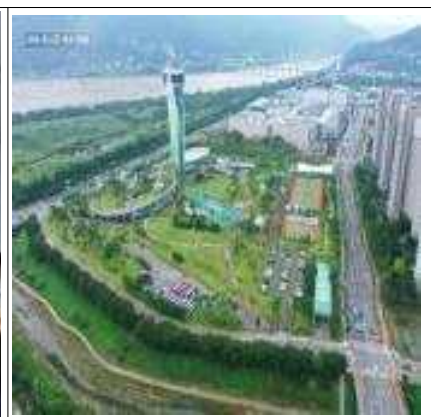
노후하수처리장 성능개선 우수사례(하남 유니온파크)
