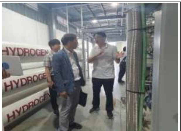
충주 바이오가스&수소시설 현장방문(9.12, 물환경정책관)
