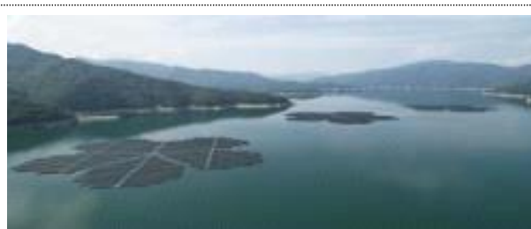
<소양강댐(양구) 수상태양광 설치 준공(11.9)>
