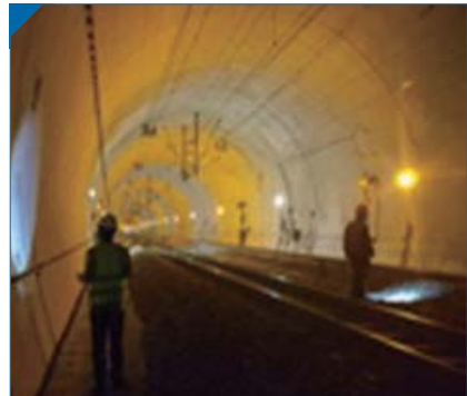
선로변형유무 및 터널 라이닝 점검 (9.12 / 선로 및 터널)
