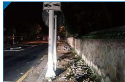
오름 담장과 파손
