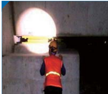
교량하부 받침 및 PSC BOX 점검 (9.12 / 교량 등 주요구조물)
