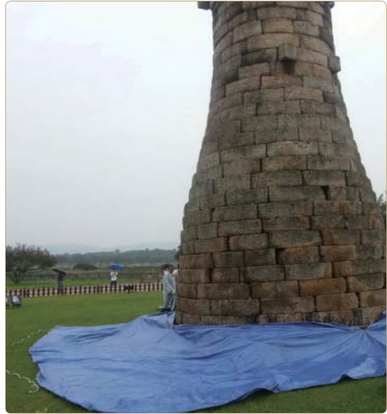
| 시설명 | 첨성대 | 피해내용 | 변이발생 추가 및 정자석 이격 추가
