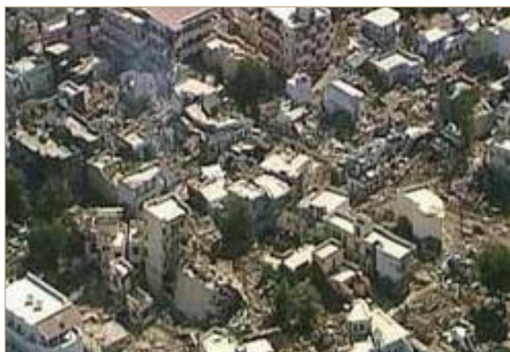
〈 부지지역의 건물 붕괴 전경 〉
